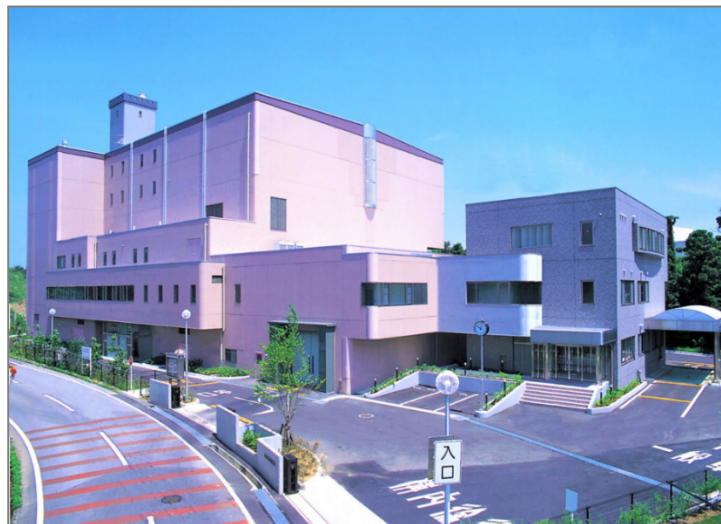
図 2-18 クリーンセンターしらさぎ全景
